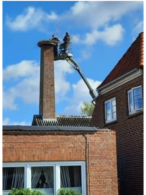
Storkereden i Sig under renovering. Foto: Ryan Metcalfe
